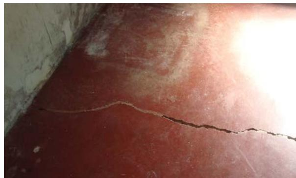
Visão de uma das rachaduras do piso, que representava risco de desmoronamento.
