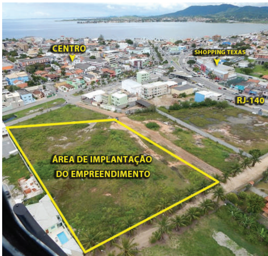
Área de implantação do Empreendimento Residencial Aldeia das Asas
